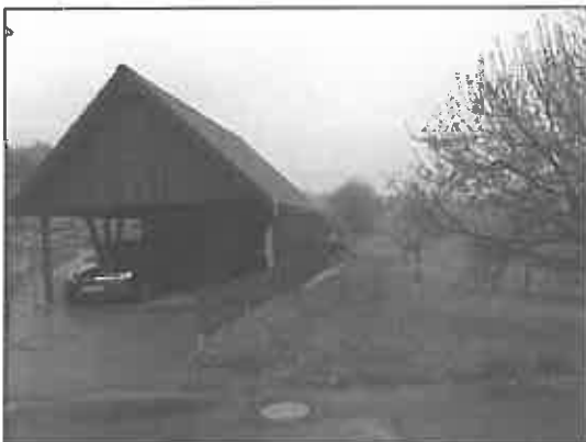
Ansicht Carport und Blick ins Plangebiet
