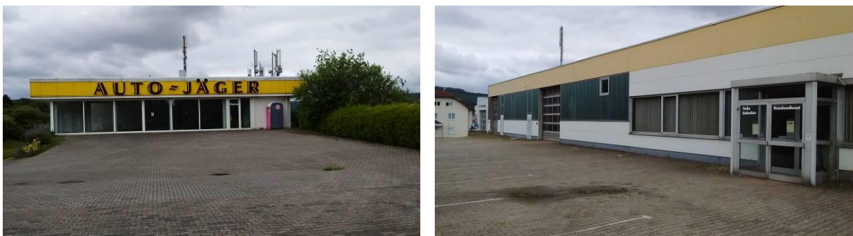
Abb. 1: Verkaufs- und Bürogebäude (links) sowie Werkstatthalle des Autohauses (rechts).
