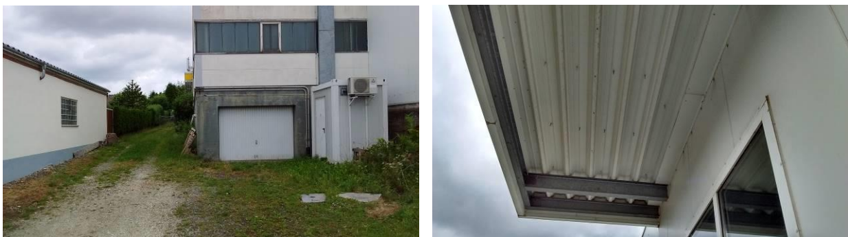
Abb. 3: Blick auf die Außenfassade des Autohauses (links) und unter einen Dachüberstand.
