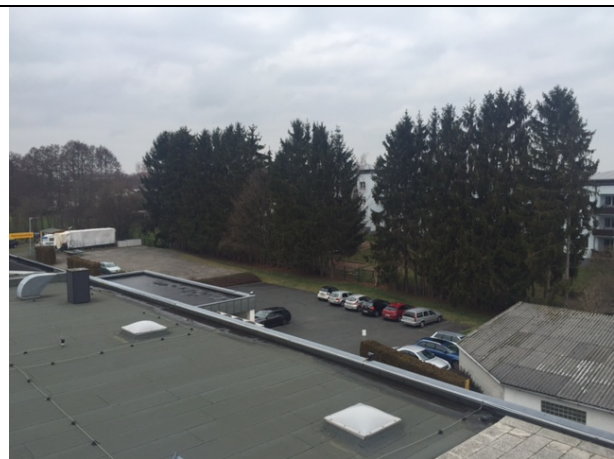
Blick nach Norden in den rückwärtigen Bereich mit Stellplätzen und Ansbach
