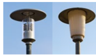
Pilzleuchten, ob neu oder alt, gehören wegen unzureichender Lichtlenkung und Abschirmung auch zu den schlechten Leuchten.
