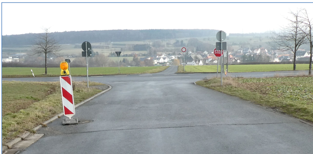
Abbildung 8: Anschlussknotenpunkt der Deponiestraße an die K723 – Blick aus Richtung Deponiestraße
