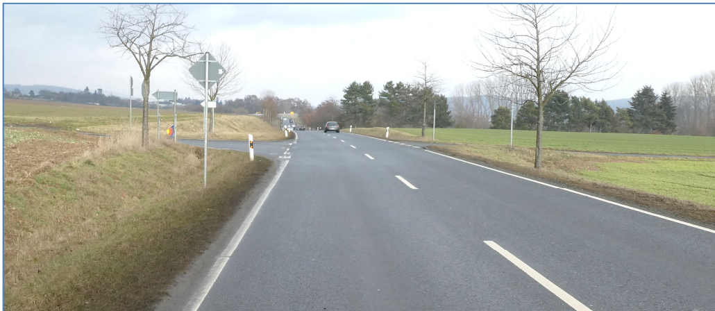
Abbildung 7: Anschlussknotenpunkt der Deponiestraße an die K723 – Blick in Richtung Usingen, links der Anschluss der Deponiestraße
