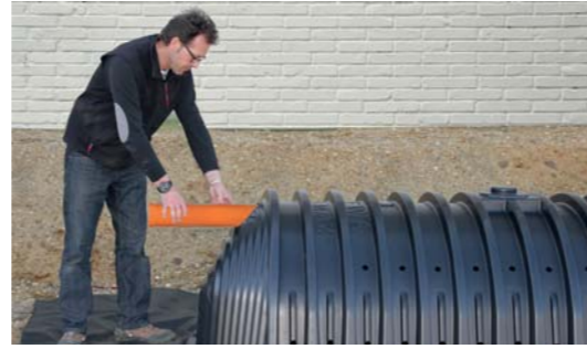
RW Zulaufrohr montieren
