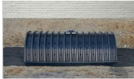
Tunnel Rigole auf GTVB 190 setzen
