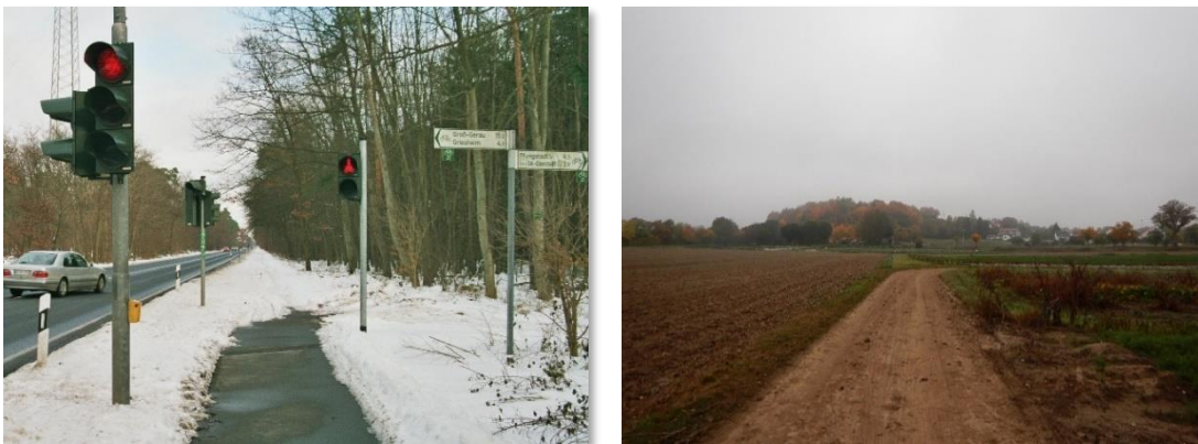
Abbildung 11: Ende eines geräumten Radweges an einer Gemarkungsgrenze / Verschmutzter asphaltierter Wirtschaftsweg
