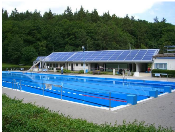
Foto 2: Thermische Solaranlage Waldschwimmbad
