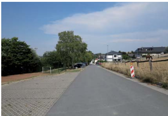
Abb. 48: Blick aus Südwesten entlang der FLJ Straße
