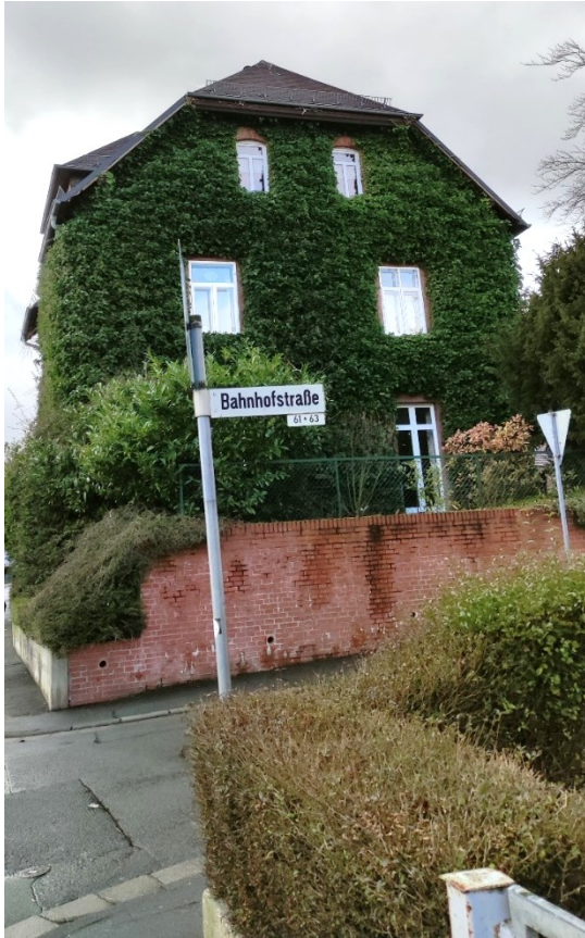
Abbildung 6) Gebäude mit Fassadenbe- grünung
