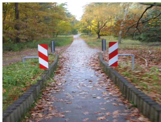
Abb. 5: Barrierefreier Ausschluss von Kraftfahrzeugen durch bauliche Verengung.
