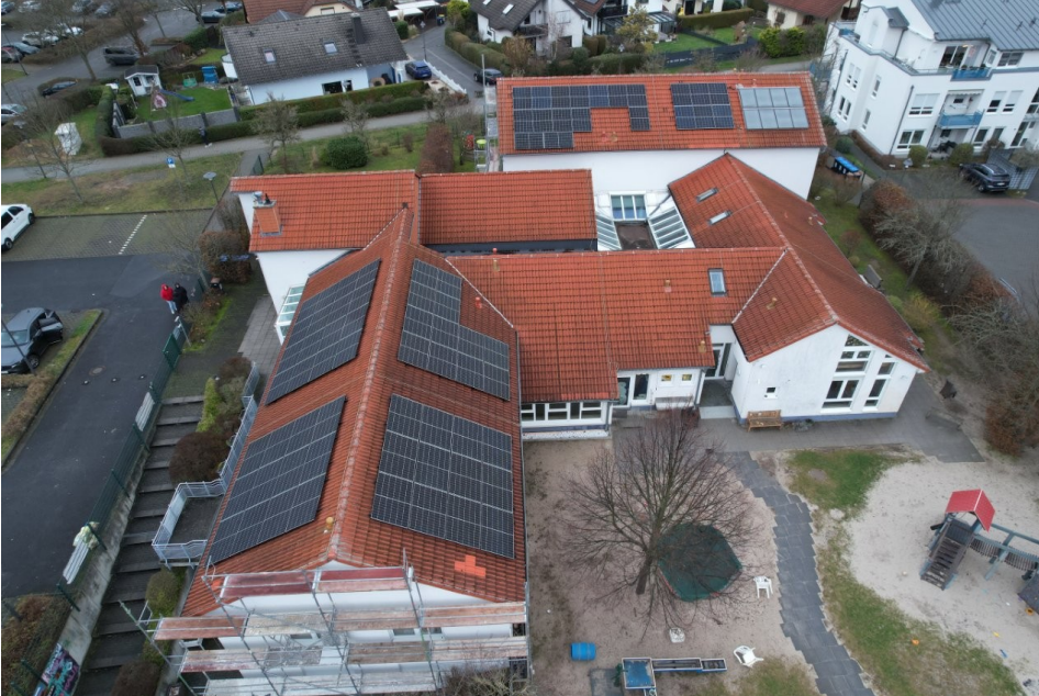
Foto – BEHT: Kita-Mitte und Jugendhaus in Neu-Anspach – Dachbelegung
