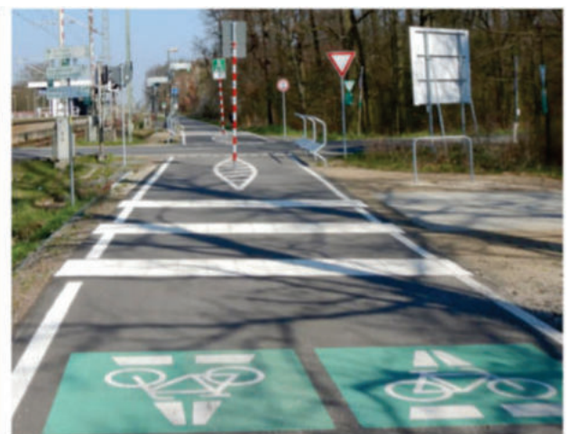
Abbildung 3: Baulicher "Rüttelstreifen" mit taktilen Elementen (Rippenplatten) zur Aufmerksamkeitssteigerung
