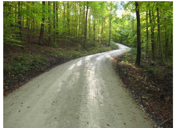
Abbildung: Beispiel gut befahrbare wassergebundene Decke
