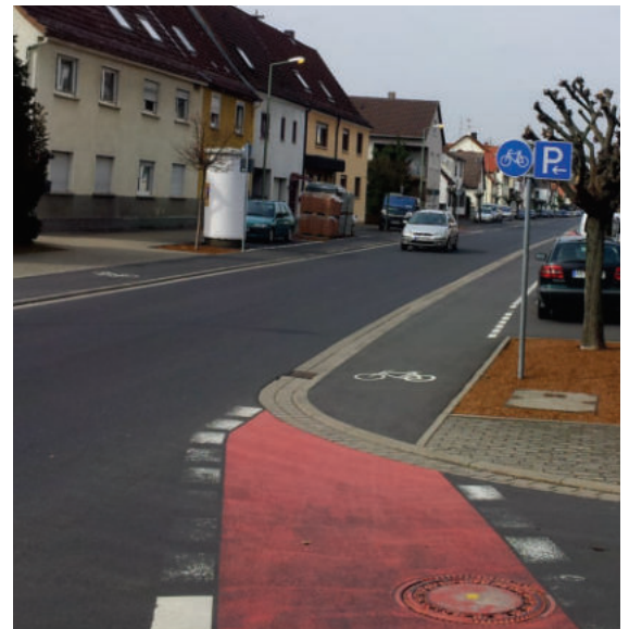
Bordsteinabsenkung Fahrbahn - Radweg, Frankfurt am Main
