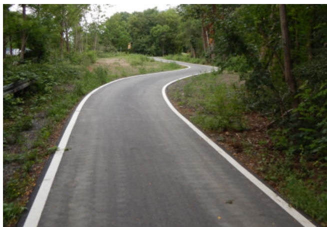
Abb. 2: Asphaltierter Geh- und Radweg mit fahrdynamischer Linienführung und Randmarkierungen
