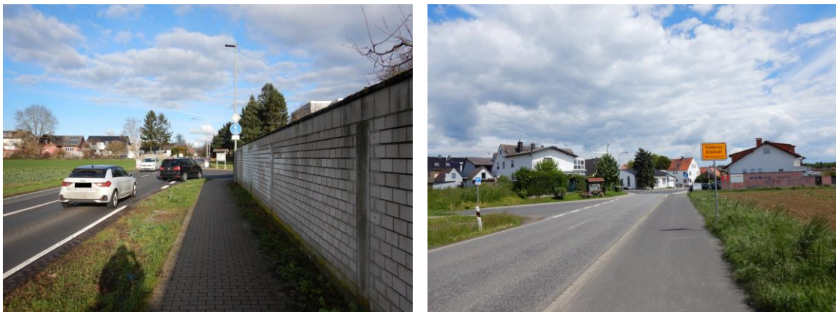
Abbildung 6: Fehlende Überführung zwischen Fahrbahn und Radweg an der K246 in Heldenbergen (links), fehlende Überführung am Ortseingang Erbstadt (rechts) (Quelle: Eigene Aufnahmen)
