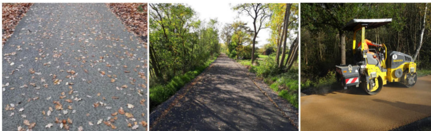
Abb. 2-3: Alternative, asphaltähnliche Oberflächen aus Basaltstein und Spezialsanden - Quelle: BioSi Balastan®, Schweizer Ideen-Werkstatt / Abb. 4: Heller Split-Mastix-Asphalt
