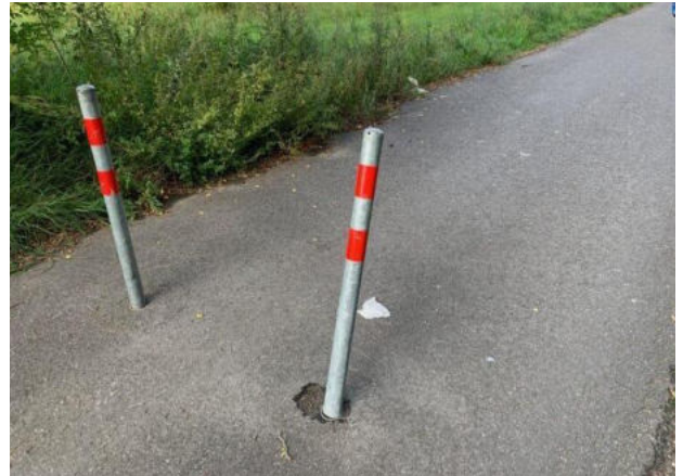
Abbildung 1: Bereits angefahrener und schiefer Sperrpfosten mit zu geringer Durchgangsbreite
