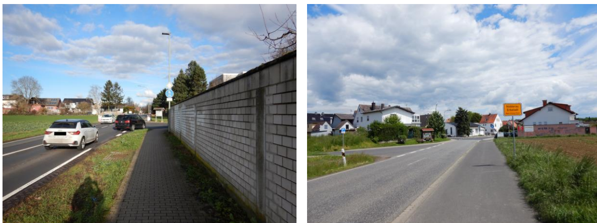
Abbildung 6: Fehlende Überführung zwischen Fahrbahn und Radweg an der K246 in Heldenbergen (links), fehlende Überführung am Ortseingang Erbstadt (rechts) (Quelle: Eigene Aufnahmen)
