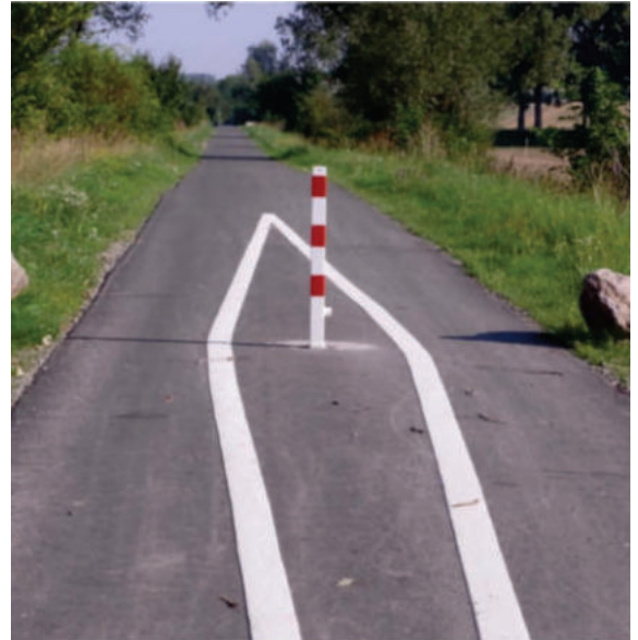
Abbildung 1: Warnmarkierung eines Sperrpfostens
