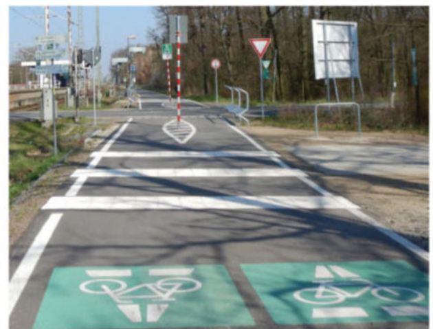
Abbildung 3: Baulicher "Rüttelstreifen" mit taktilem Elementen (Rippenplatten) zur Aufmerksamkeitssteigerung
