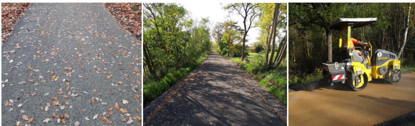
Abb. 3-4: Alternative asphaltähnliche Oberflächen aus Basaltstein und Spezialsanden (Quelle: BioSi Balastan®, Schweizer Ideen-Werkstatt) / Abb. 5: Heller Split-Mastix-Asphalt
