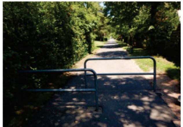
Abbildung 1: Umlaufsperrern mit zu geringer Durchgangsbreite Überlappung der Gitter und ohne (reflektierende) Markierung
