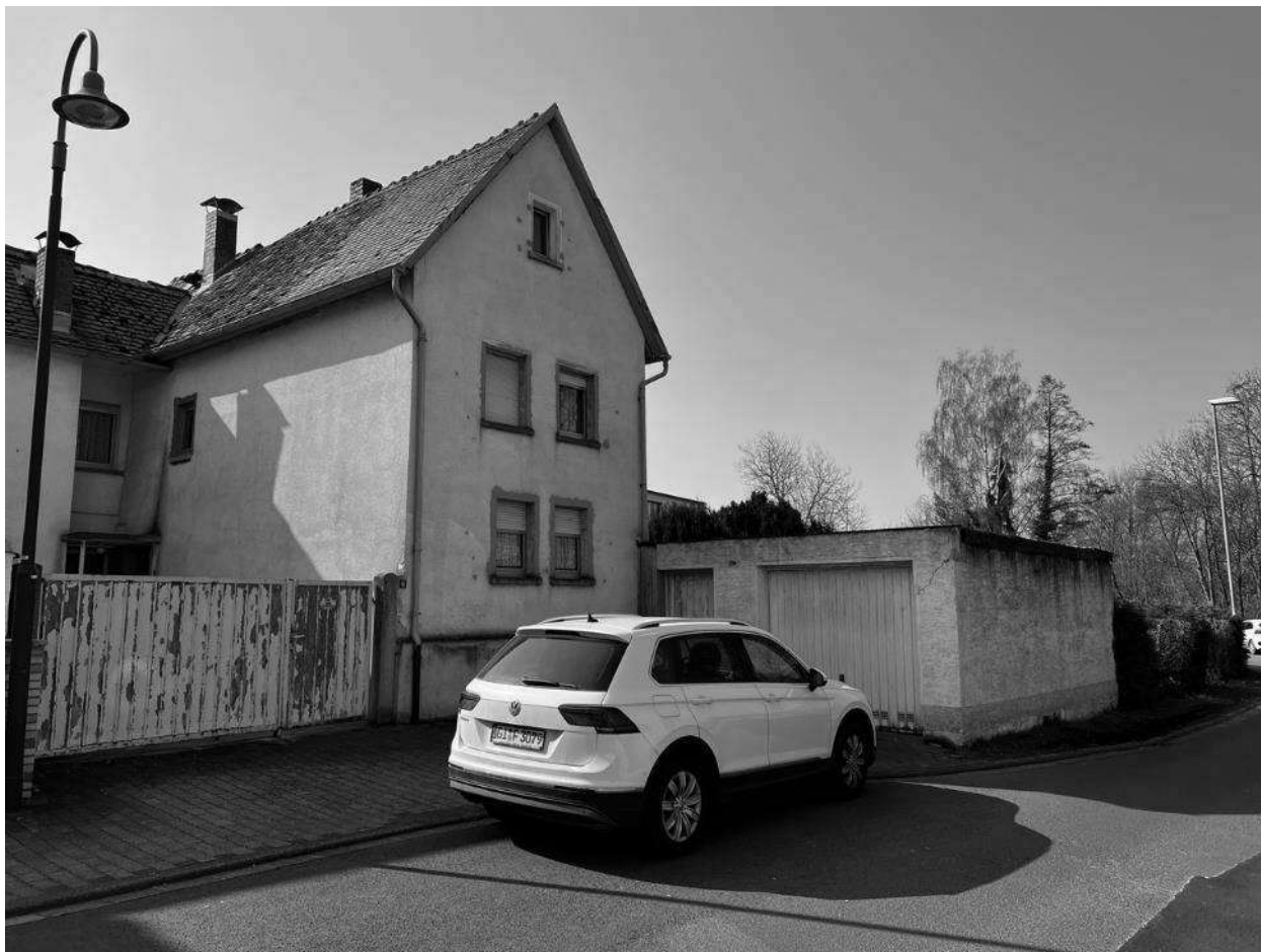
Usagasse 6: Das abgängige Gebäude entspricht nicht mehr zeitgemäßen Wohnansprüchen
