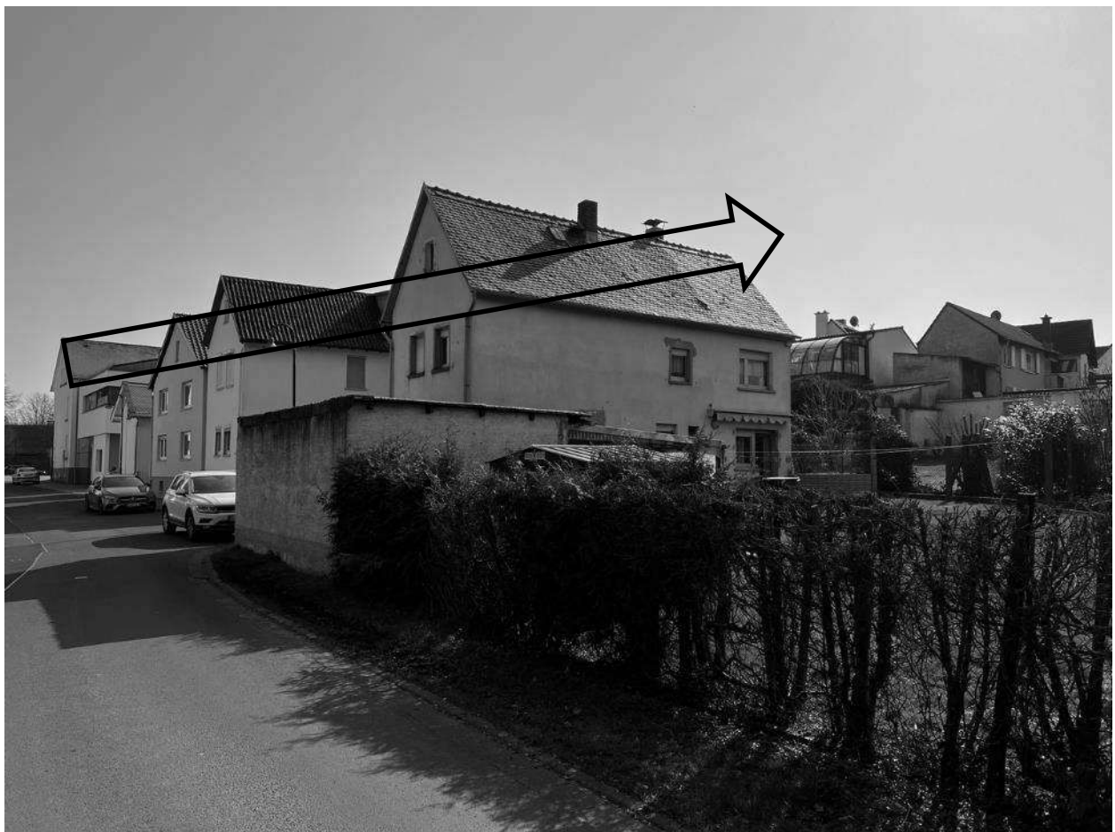
Blick in die Usagasse von Westen her: im Mittelgrund das abgängige Gebäude und die deplatzierte Garage. Die Bauflucht der Usagasse wird für das neue Gebäude aufgenommen.
