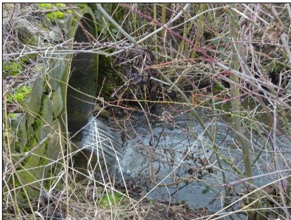
Abb. 29: Kleiner Sohl sprung an der Wegeüberfahrt zw. Bundesstraße und Usa.
