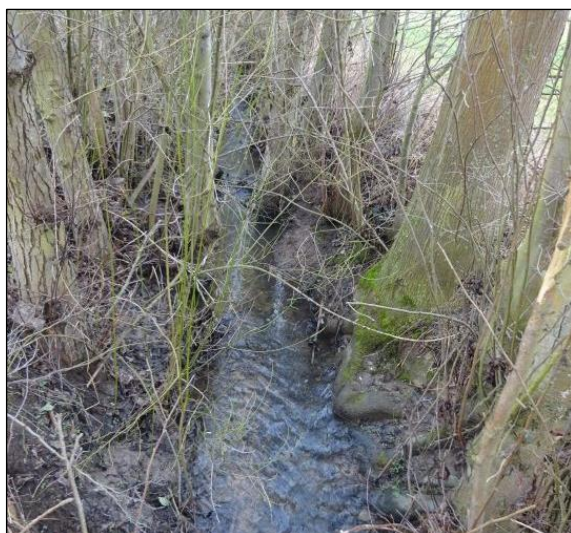
Abb. 25: Grünverbau am Aitzenbach
