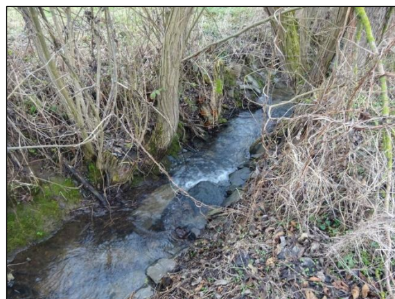
Abb. 26: Sohl- und Uferverbau mit Steinsatz
