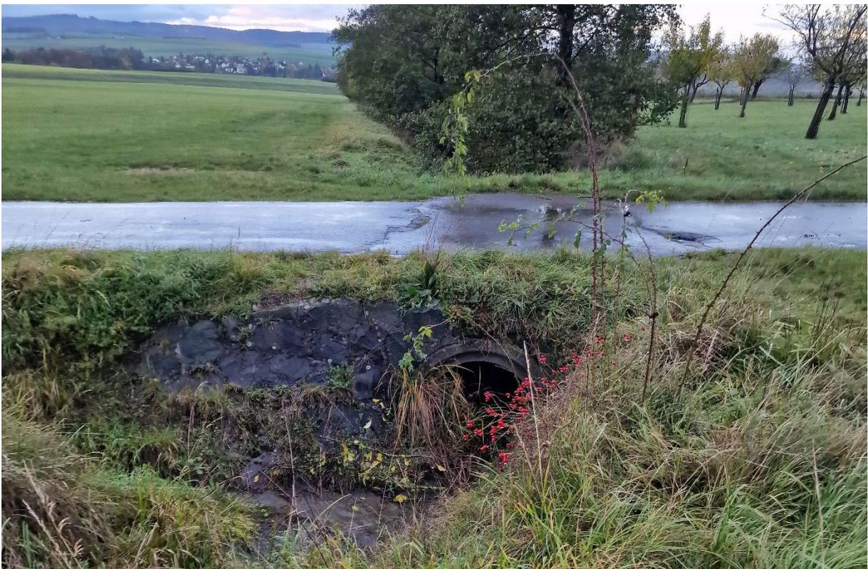
Abbildung 20: Verkrautete und sedimentierte Verrohrung.
