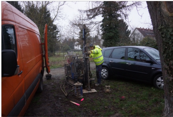
Abbildung 4: Durchführung der Bohrsondierung BS 8
