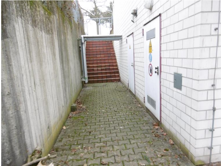
Abbildung 4: Gully gegenüber Zugang Chlorgasraum
