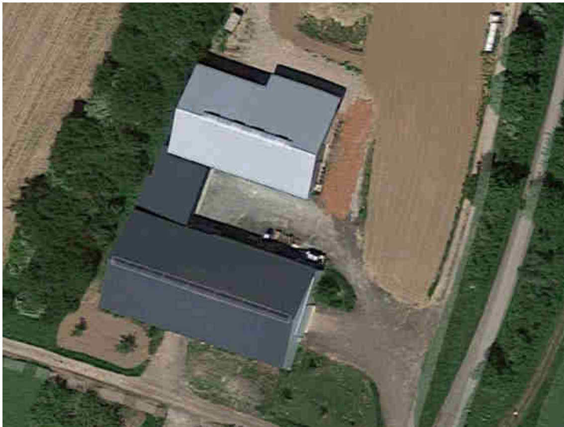
Abbildung 3: Hofstelle des Geflügelbetriebs, Luftbild Bestand
