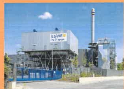
Biomasseheizkraftwerk der ESWE
