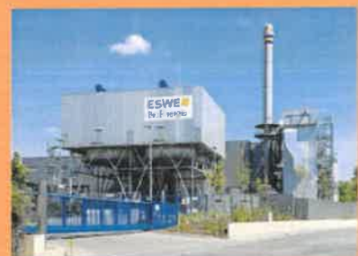
Biomasseheizkraftwerk der ESWE
