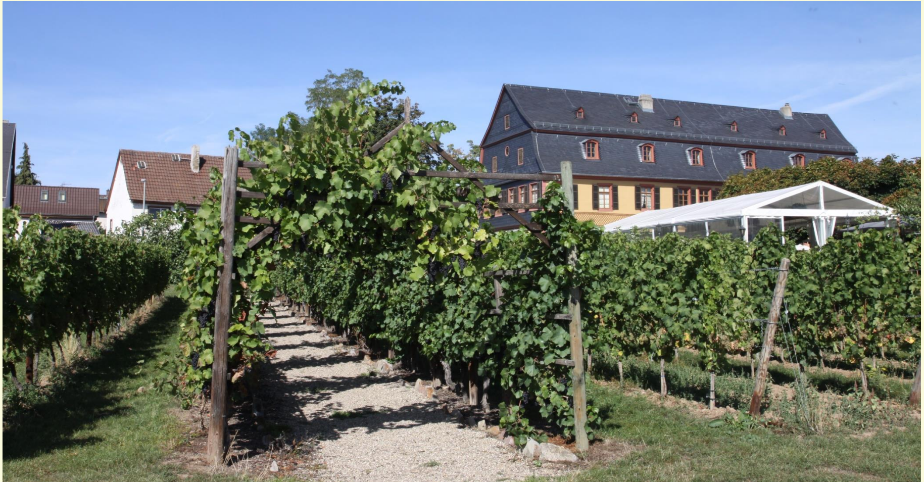
Brentanopark – Blick auf das Brentanohaus von Süden, September 2019
