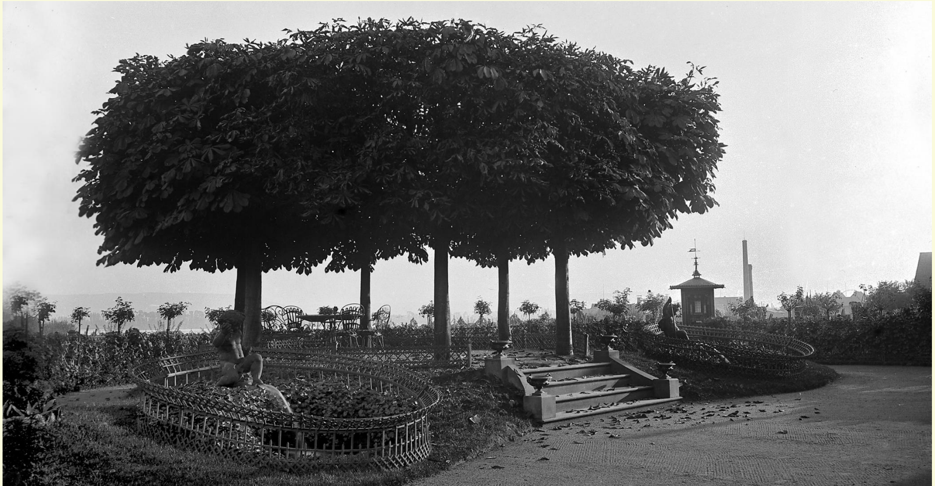
Brentanopark – Terrasse, Blick nach Südwesten, 1889 - Quelle: Digitales Gebäudearchiv Brentanohaus
