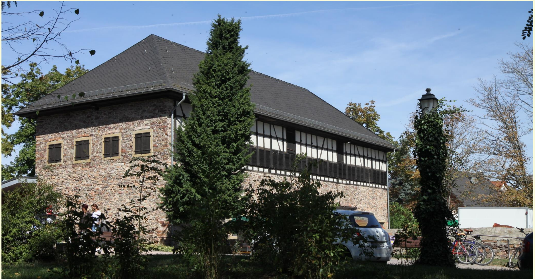
Brentanoscheune, Blick von Süden, September 2019
