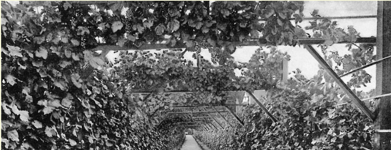
Brentanopark – Fotos aus den 1920er Jahren - Quelle: Digitales Gebäudearchiv Brentanohaus
