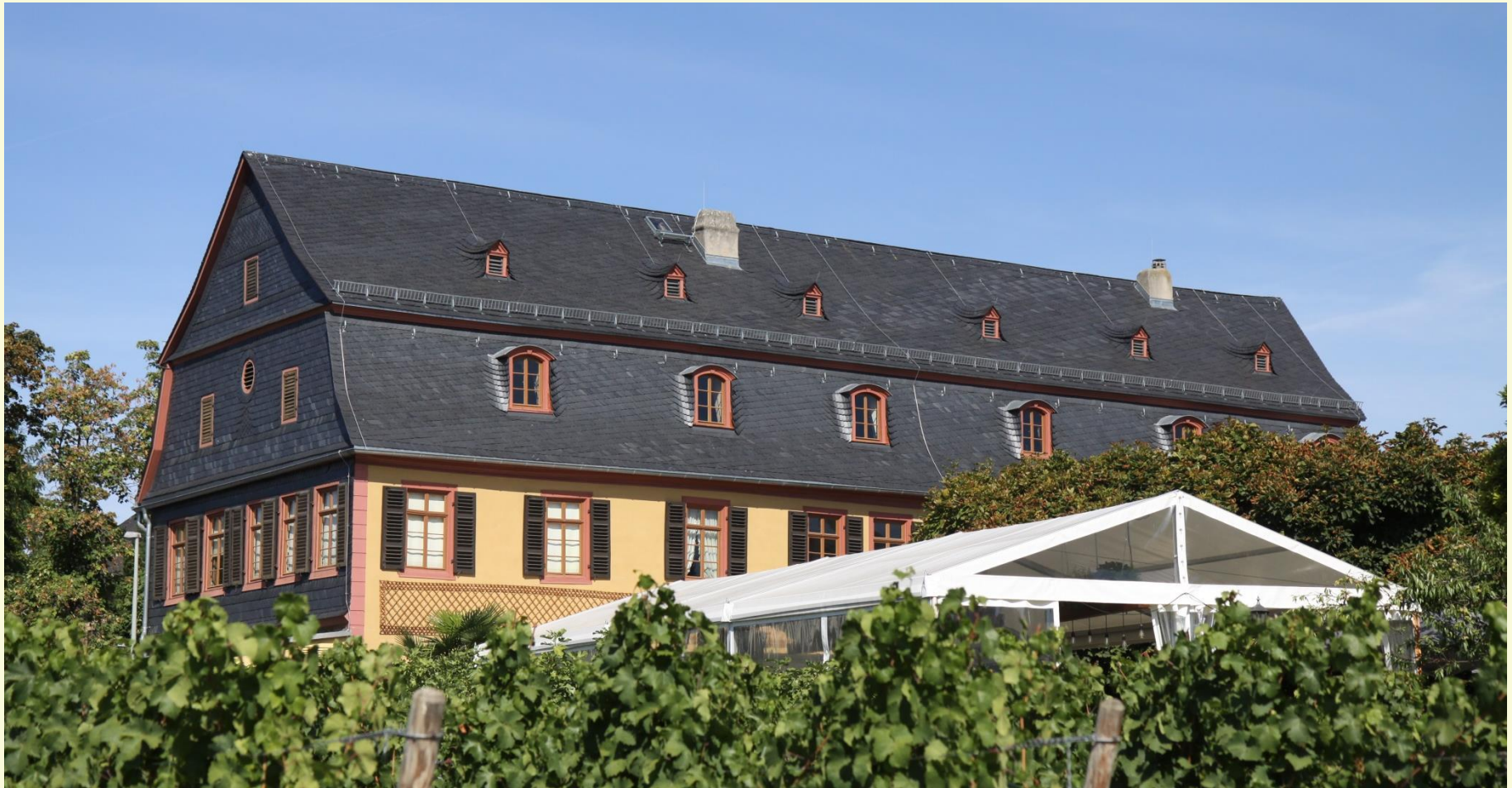
Brentanohaus | Brentanopark, Blick von Südosten, September 2019
