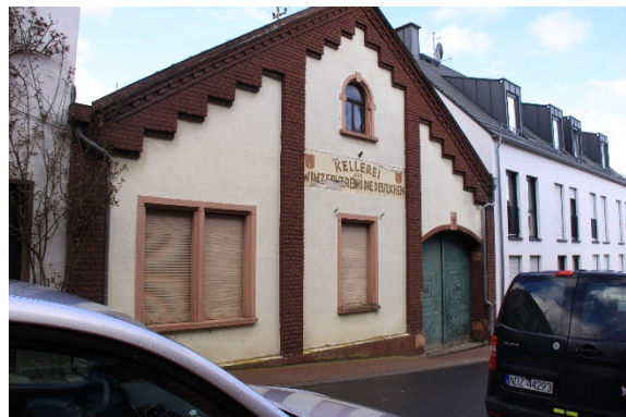
Gebäude des Winzervereins
