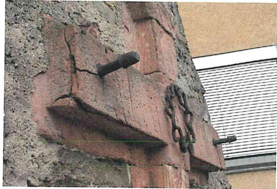
**Abb. 3:** Kreuz aus Sandstein infolge Rostsprengung und Frosteinwirkung stark gerissen.
