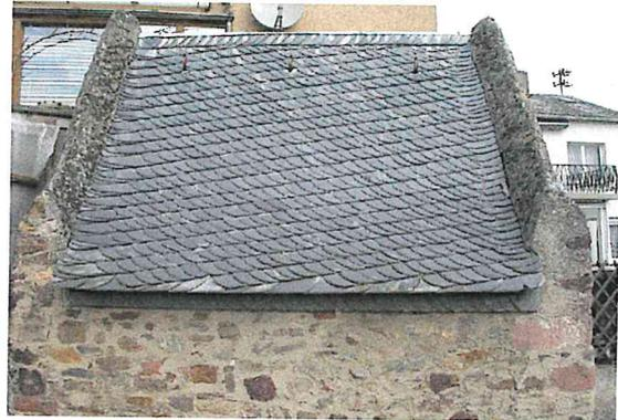
**Abb. 4:** Dachkonstruktion anfällig gegenüber eindringendem Regenwasser (über gerissen Mörtel innerhalb der Seitenteile).
