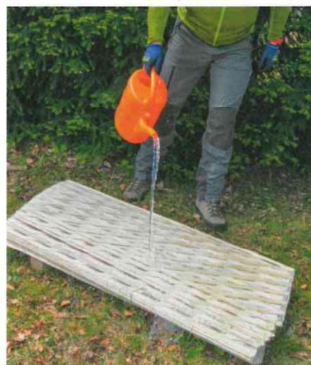
Abb. 3: Die Eschlbeck-Hülle wird flach geliefert. Um sie biegsam zu machen, wässert man sie vor der Montage.
