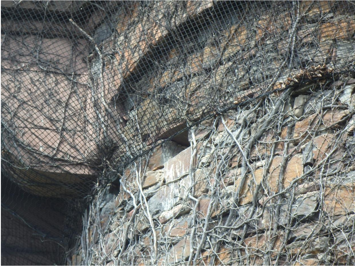
Abb. 4: Einflug des Turmfalkennests im Wasserturm.
