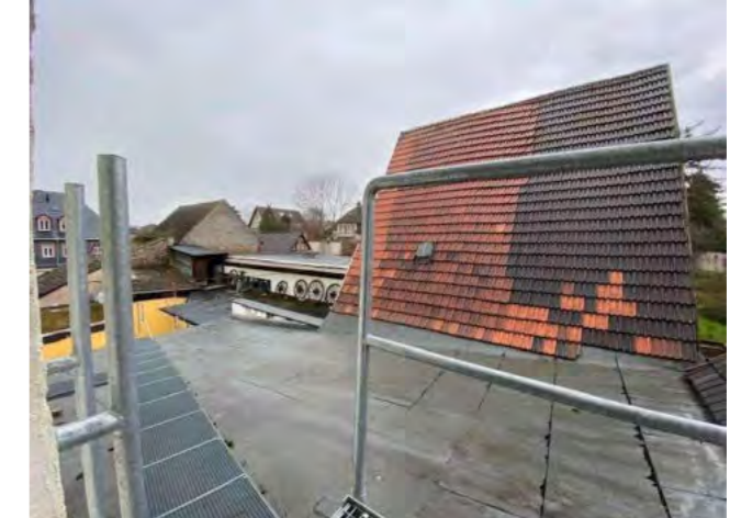
Scheune / Ziegeldach an der Südseite
