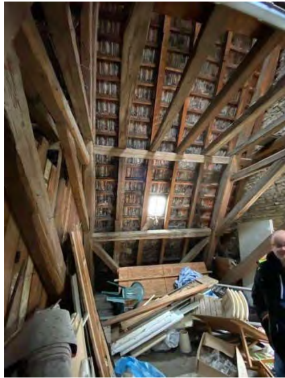
Scheune / Dachstuhl 1.OG
