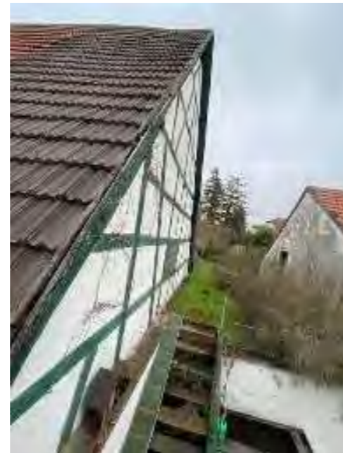
Scheune / Blickrichtung Nord mit Fassade an der Grundstücksgrenze
