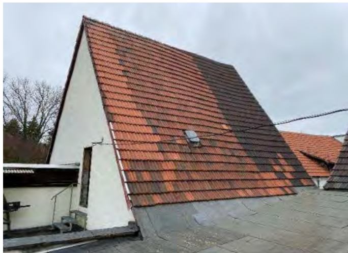
Scheune / Blickrichtung Nord
