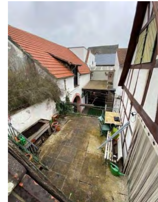
Scheune / Blick aus dem Dach zum Hof Hauptstraße 72
