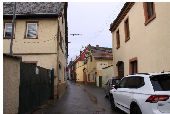
Römerstraße mit den Vorderhäusern der Hofreiten Teilweise besteht hoher Sanierungsbedarf
