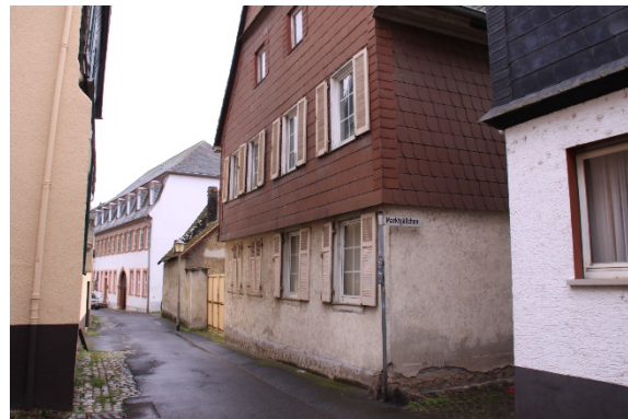
Historisches Wohngebäude mit hohem Sanierungsbedarf
