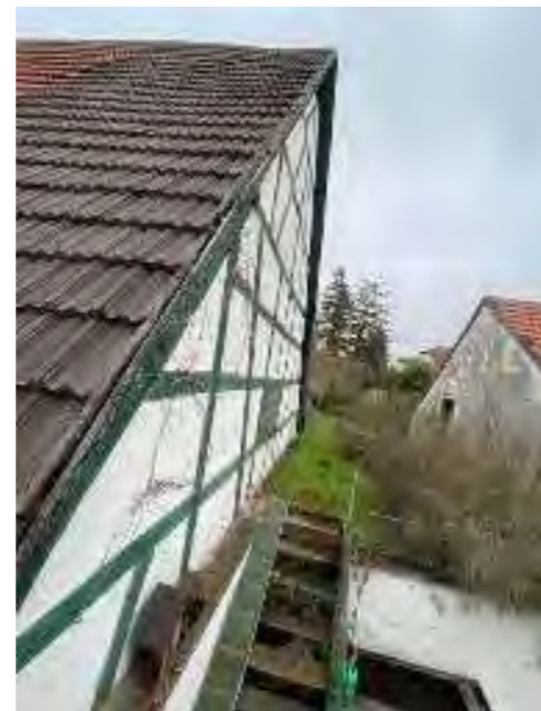
Scheune / Blickrichtung Nord mit Fassade an der Grundstücksgrenze
