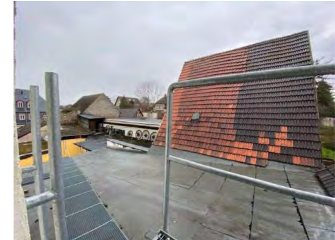
Scheune / Ziegeldach an der Südseite
