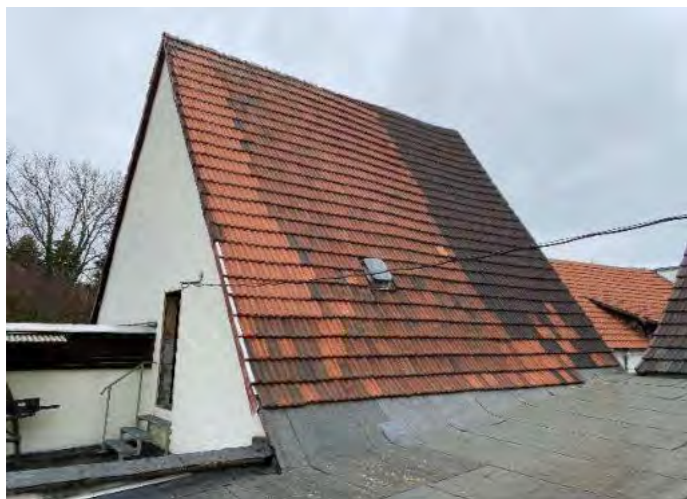
Scheune / Blickrichtung Nord
