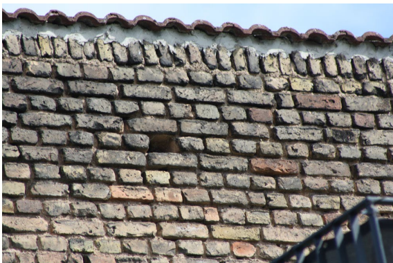
Abb. 3: In der mittleren, der drei konstruktionsbedingten Nischen an der südlichen Fassadenseite, befindet sich 1 ehemaliges Hausrotschwanznest.
