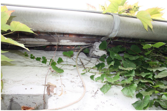
Abb. 12: der Dachrand bietet im Bereich der Sparren Einschlu pm glichkeiten auf den Dachboden. Mit Nistst tten ist aufgrund der vielen Ratten hier allerdings nicht zu rechnen.
