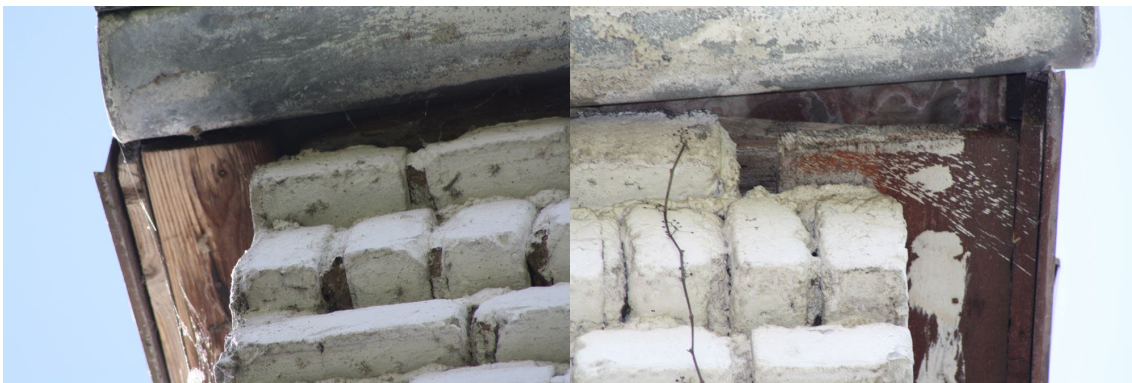
Abb. 7: An den n6rdlich gelegenen Dachecken der Giebelseiten befinden sich Einschluflmöglichkeiten in den h6lzernen Dachrand. An der westlichen Dachecke ist hier 1 ehemaliges Haussperlingsnest vorhanden.
