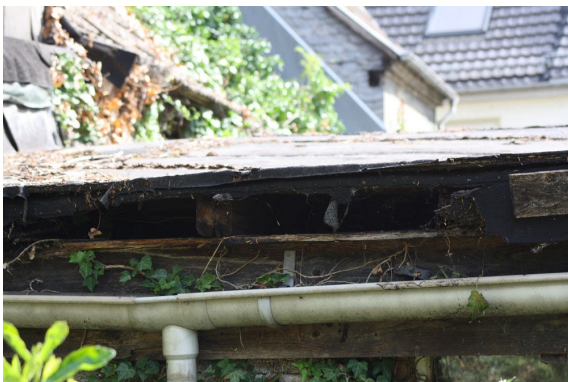
Abb. 20: Der westliche Dachrand bietet Tieren Einschlu fm glichkeiten in das Innere des Gartenhauses (C).
