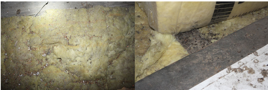
Abb. 17: Auf dem Dachboden befindet sich Kot von Mäusen und Ratten.
