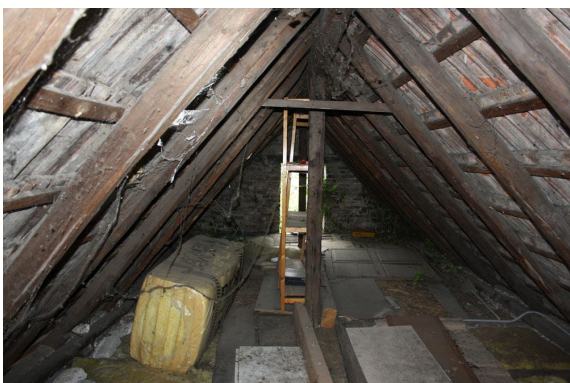
Abb. 14: Der Dachboden des Nebengebäudes (B).
