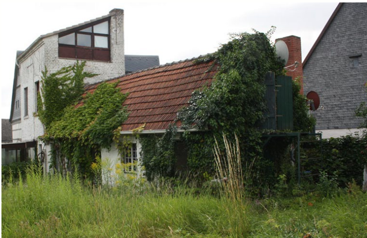
Abb. 2: Nord- und Westansicht des Wohngebäudes (A1) mit angebautem Wintergarten (A2).
