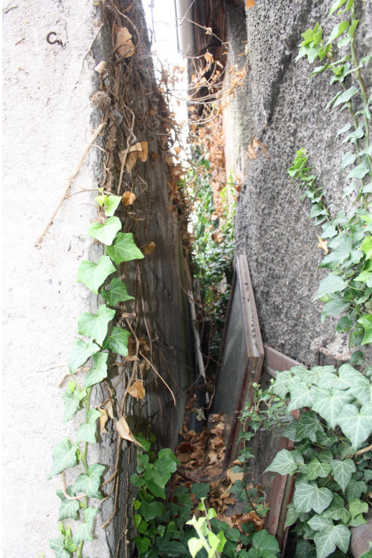
Abb. 26: Weiterer Schaden an einem Betonhohlstein in der Decke des PKW-Unterstandes, mit Nistpotential für Gebäudebrüter.
