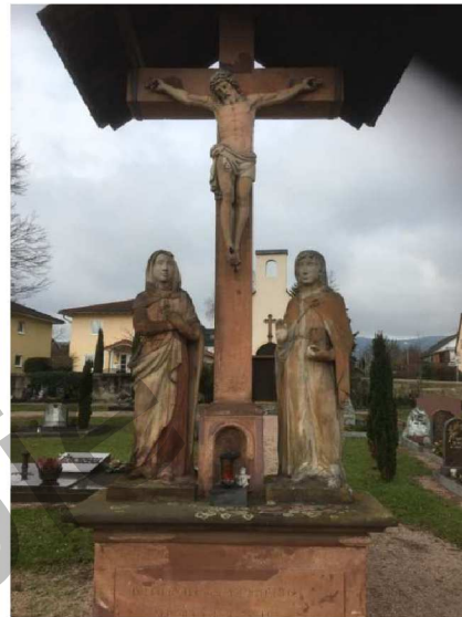
Kreuzigungsgruppe vor Sanierung
