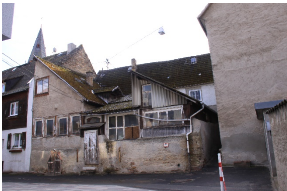
Hoher Sanierungsbedarf in der Zangerstraße
