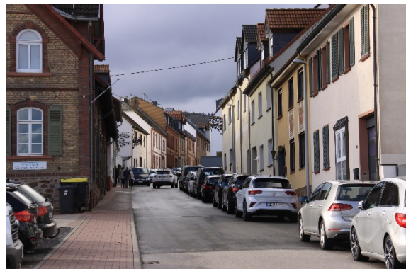
Blick in die Hattenheimer Straße (Erweiterungsgebiet um 1900)
