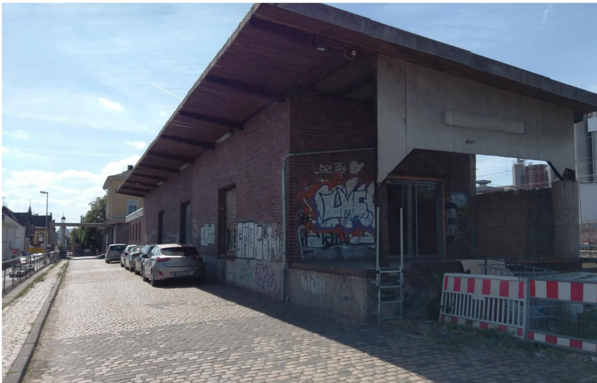
Nebengebäudeteil „Güterhallen“, Ansicht von Süden (Straßenseite); im Hintergrund Nebengebäudeteil „Verwaltung“ und historischer Bahnhof
