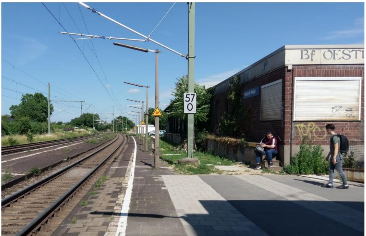
Nebengebäude Güterhallen + Verwaltungsteil, Ansicht von Norden (von Gleisanlagen)
