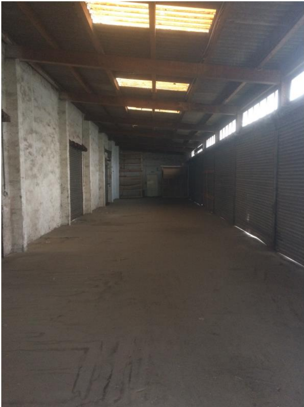
Nebengebäudeteil „Güterhallen“, Innenansicht (Rolltore, zum Be- und Entladen der Güterzüge)
