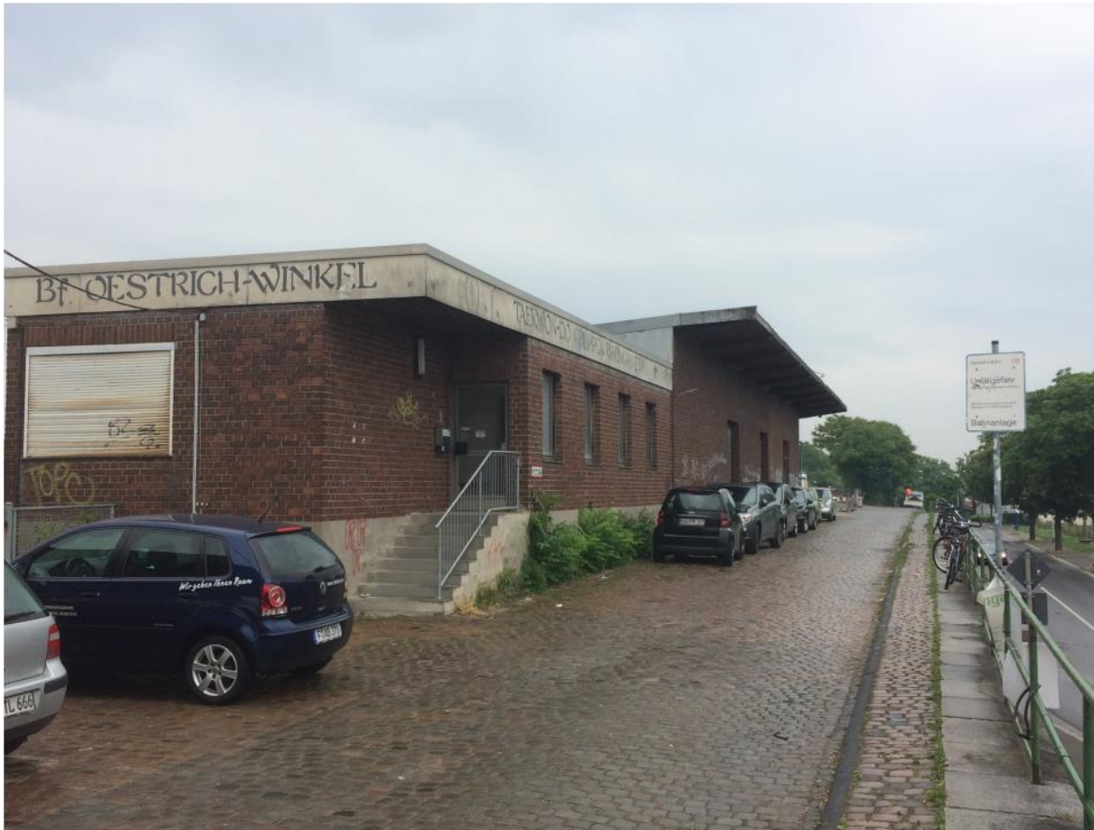
Nebengebäudeteil „Verwaltung“, im Hintergrund Güterhallen“, Ansicht von Süden (Straßenseite)
