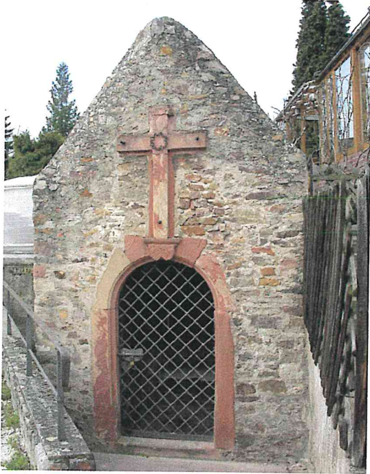
Abb. 1: Übersicht der Kapelle mit Eingangsbereich.
