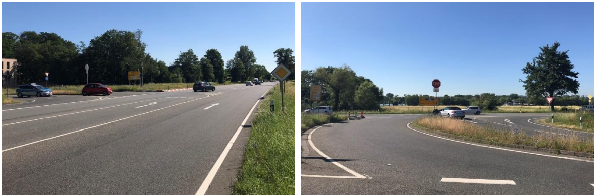
Abb. 7 Anschluss Oestrich-Ost der B 42a an die B 42
