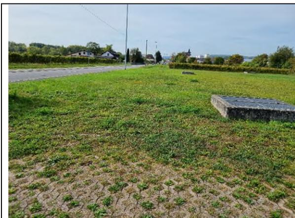
Foto 19: Wiesennutzung über unterirdischen Bauwerk mit einem Erschließungsweg (Rasengittersteine)
