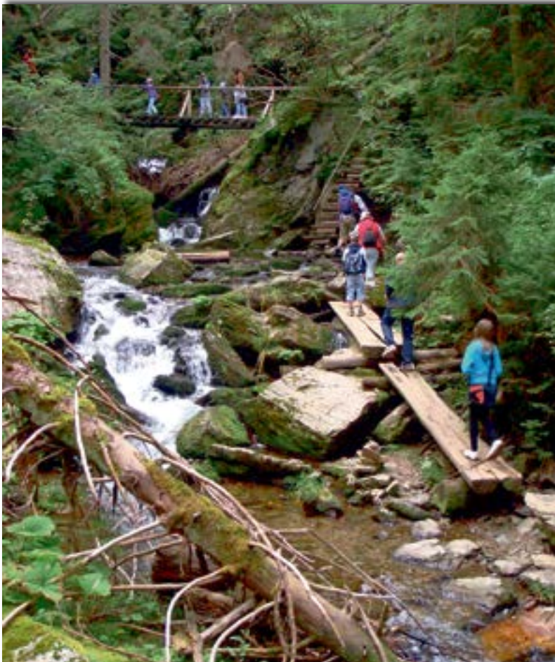
Ein schöner, einladender Wanderweg. Die Kunstbauten – Holzbohlen, Treppen, Brücken – und Gefahrenstellen bedürfen der laufenden Kontrolle.
