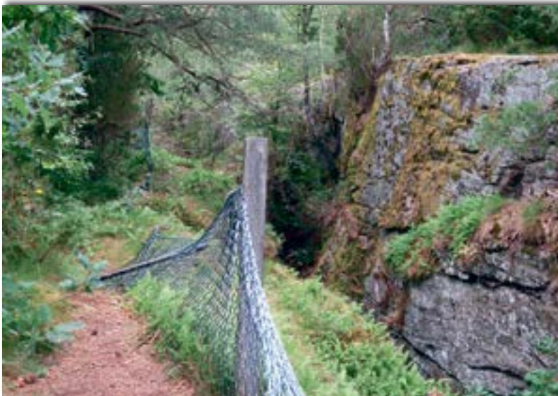
Wer eine Absperrung – wie hier neben einer zehn Meter tiefen Schlucht – baut, muss dafür sorgen, dass sie stets in Ordnung ist. Foto: Reinhard Wolf
