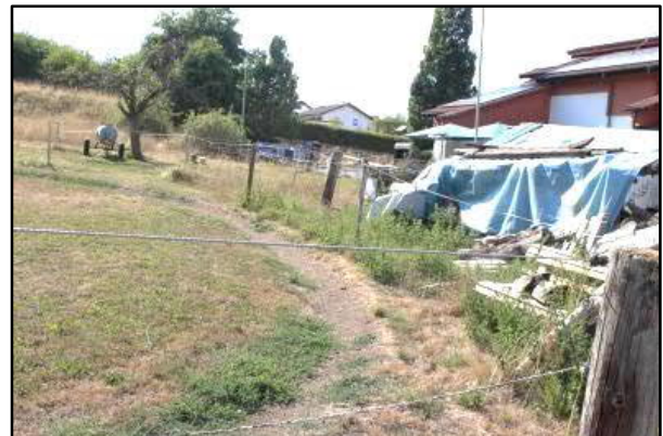
Abbildung 10: Reitbahn mit angrenzender Lager-/ Unterstandfläche
