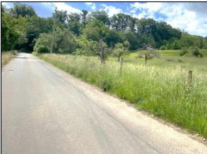
Abbildung 6: Asphaltierte Straße zum Sportplatz mit Bankett und artenarmen Grassaum
