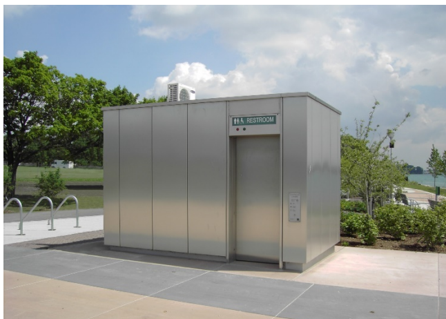
Bild 3: Edelstahlfassade WC-Anlage Detroit/USA
