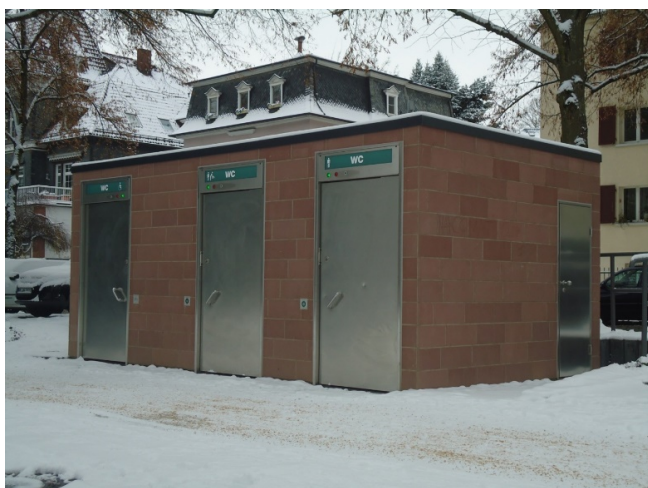
Bild 1: Buntsandsteinfassade WC-Anlage Bad Homburg
