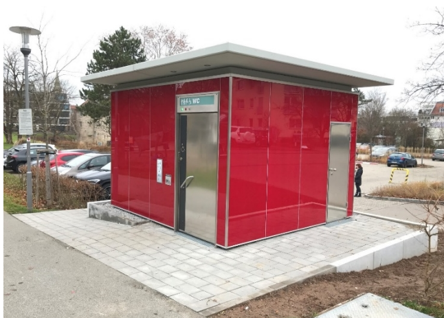
Bild 4: Glasfassade WC-Anlage Schorndorf
