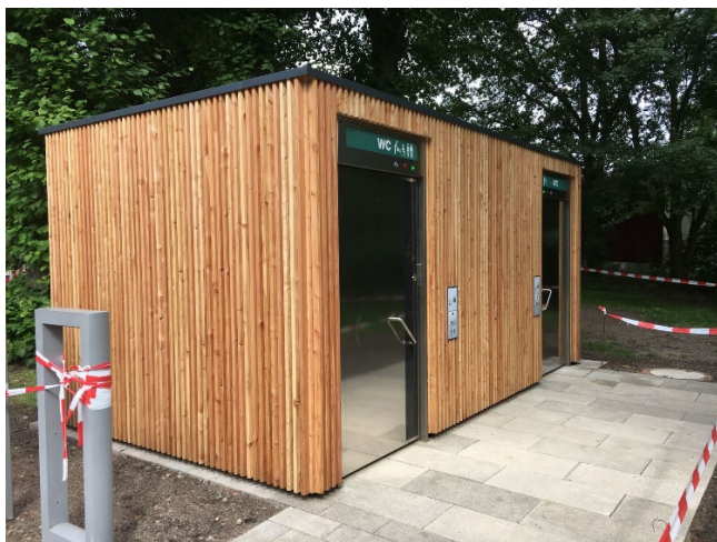
Bild 2: Lärchenholzfassade WC-Anlage Hamburg
