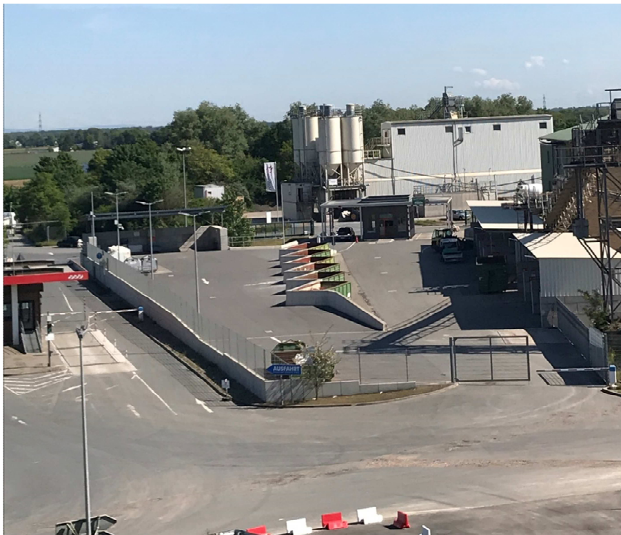
Abbildung 6: Containerbefüllung; beispielhaft Wertstoffhof Büttelborn
