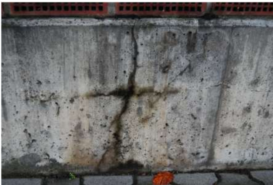
Beispiel: Rissbildungen teilweise mit Durchfeuchtung, Trogbauwerk Schnelser Weg
