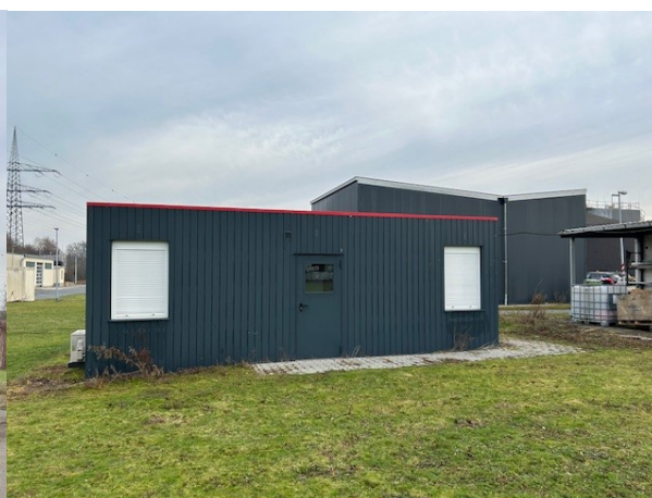
Containeranlage (im Hintergrund Stahlbau-
