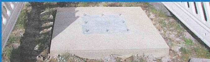
Grundmaße 2,00 x 2,00 x 1,25 m verzinkte Rohrsäule als Kippmast mit U-Profilen, Gesamthöhe ca. 5,50 m
