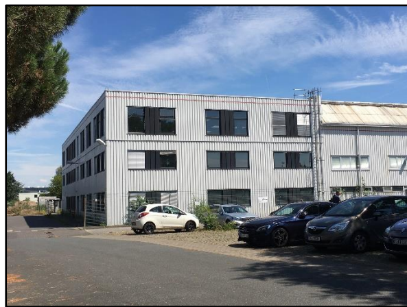
Abbildung 5: Fertigungshalle mit Parkplatz
