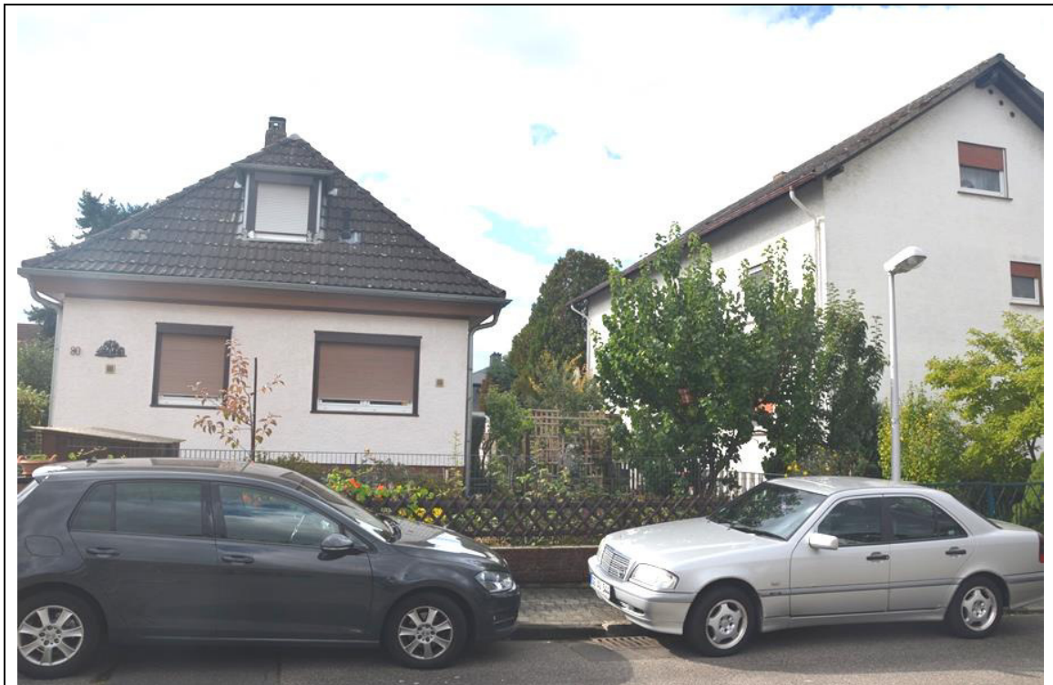
Abbildung 12: Einzelhausbebauung mit Verdichtungspotenzial (links)
