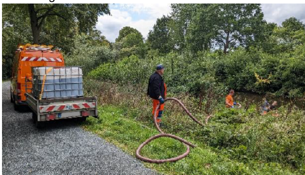
Abbildung 2: Ausbringen des Reaktionsmaterials
