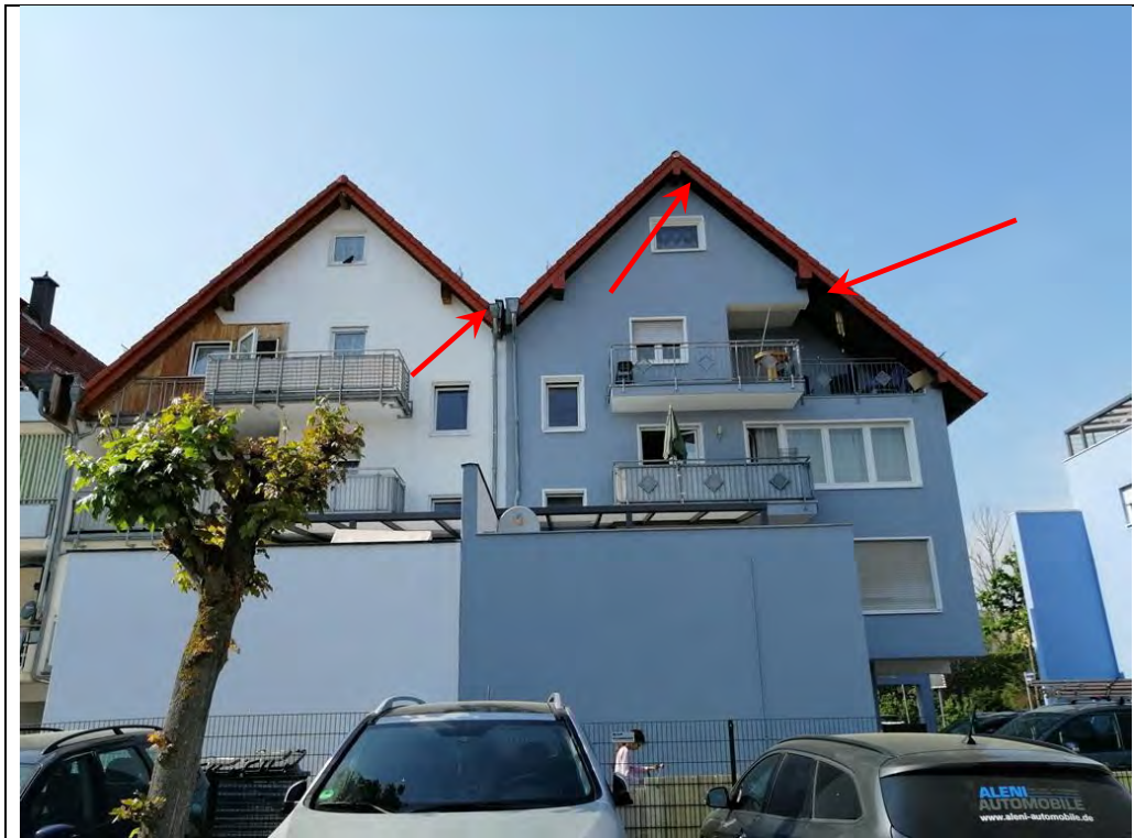
Abbildung 9: Rückseite der jüngeren Wohn- bzw. Mischbebauung im südwestlichen Änderungsbereich mit bedingtem Nistpotenzial an Dachüberständen
