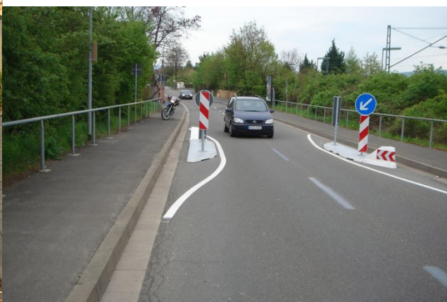
Bild 4: Temporäre Fahrbahneinschnürung mit Recyclingelementen
