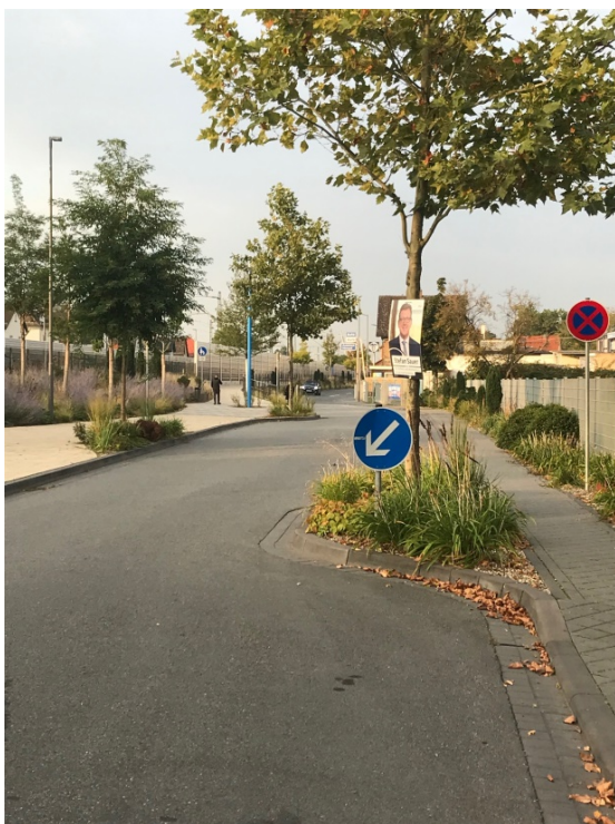
Bild 3: Bauliche Fahrbahneinschnürungen Karlstraße
